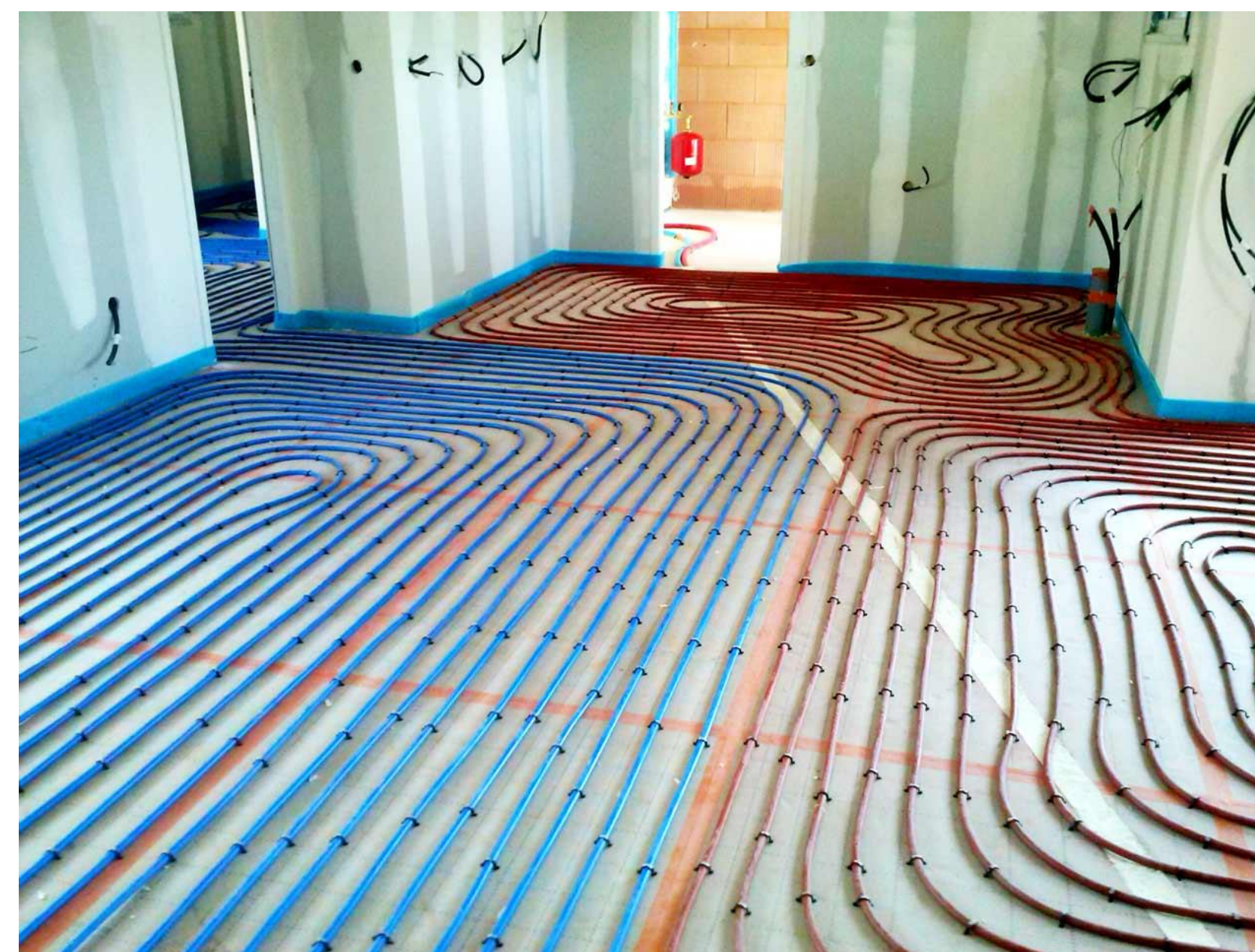
photo: dépose des serpentins de chauffage au sol
