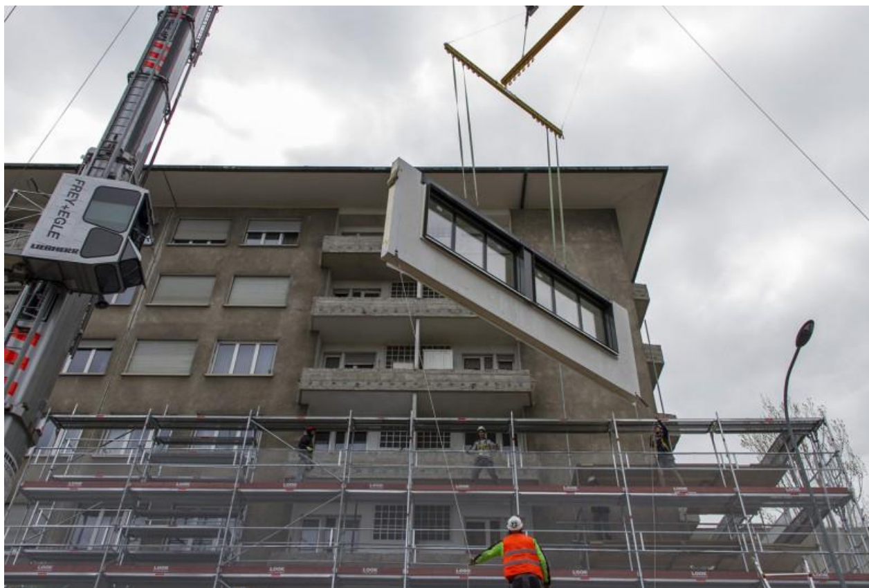
La Cigale, pose des loggias, 2014 Image Baud et Früh
