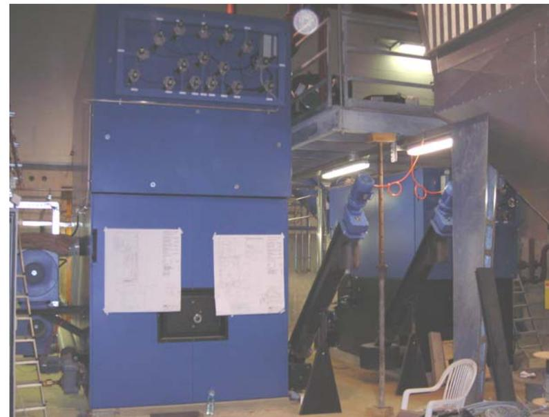
Au premier plan, la chaudière principale de 2MW qui alimente le réseau de chaleur et au second plan la chaudière secondaire de 650kW destinée à la production de l'eau chaude sanitaire en période estivale. (photo jmz)
