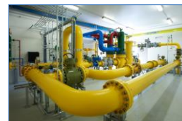
Construction de postes d'interconnexion et de détente
