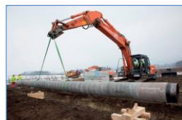
Construction et entretien de gazoducs haute pression
