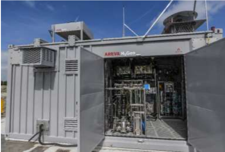
AREVA H2Gen Électrolyseur PEM 10 Nm 3 H2/h
