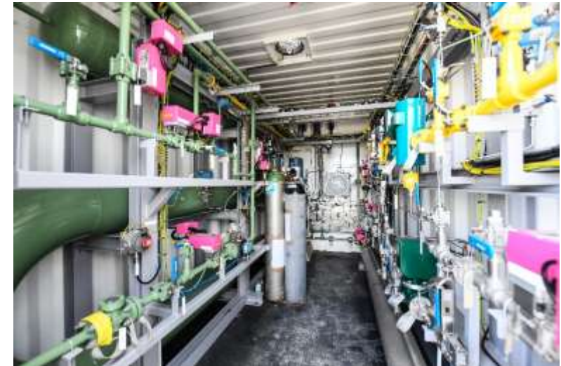
GRDF Poste d'injection H2 50 Nm 3 H2NG /h < 20 %vol. H2
