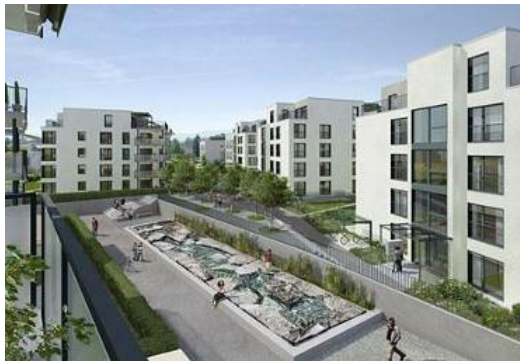
Réseaux de chauffage
