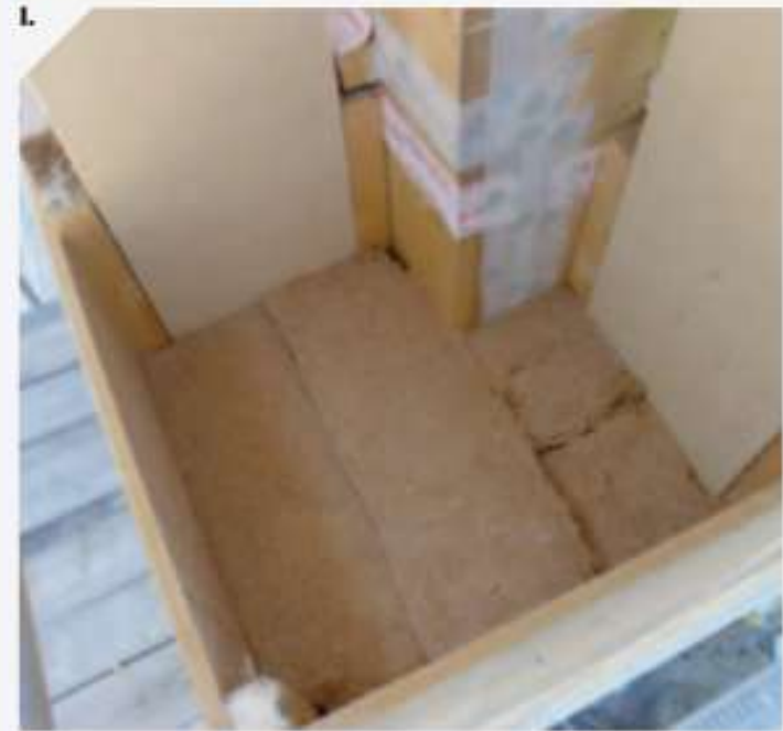
▲ I. VUE DE L'ISOLATION (AVANT REMPLISSAGE AVEC DE LA CELLULOSE).
