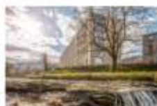
Sihlbogen, Zürich Entzertifizierung 2015, nun in Betrieb in Betrieb seit 2013/2014 Baugenossenschaft Zur Linden
