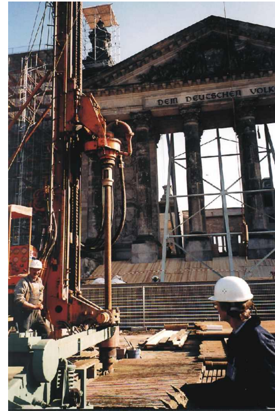
Abteufung der Bohrung Am Reichstag 1/86
