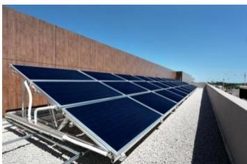
240 m<sup>2</sup> de capteurs haute température (70 à 95°C)
