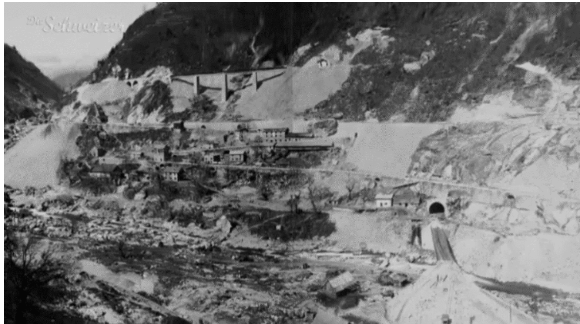
Gotthardrampe im Bau vermutlich bei Giornico Biaschina TI, Bildquelle: Sendung "Die Schweizer" Teil 4 des Schweizer Fernsehens vom 28. November 2013
