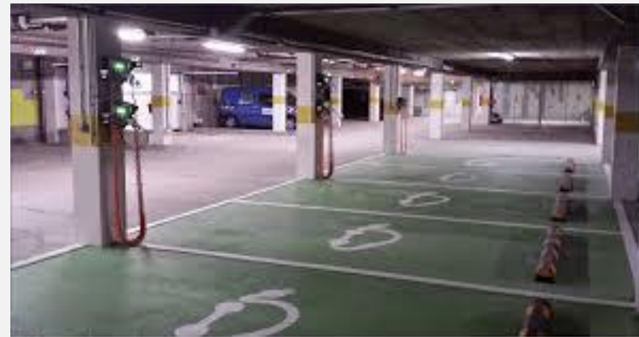
Bornes de recharge dans un parking souterrain.
