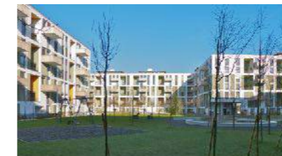
2012 Klee, GBMZ, Hagenbrünneli
