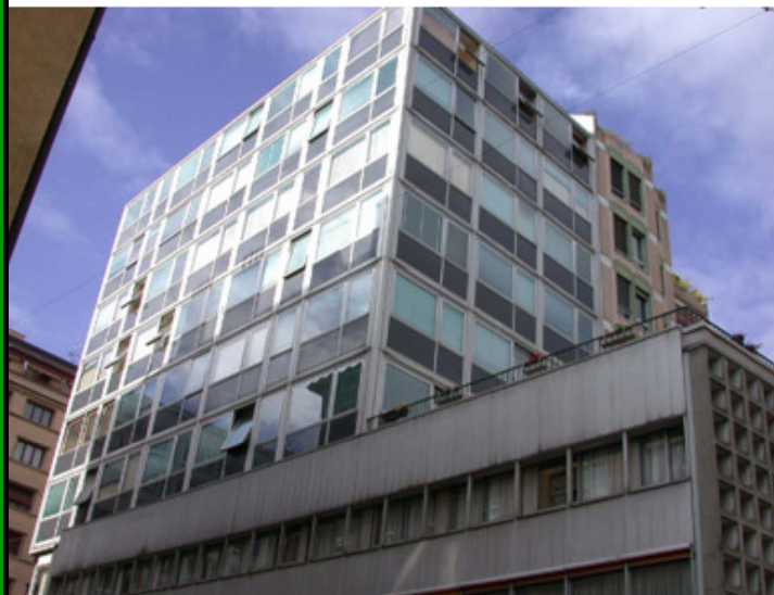
Projet d'assainissement de la Maison de l'Ancre, Genève
