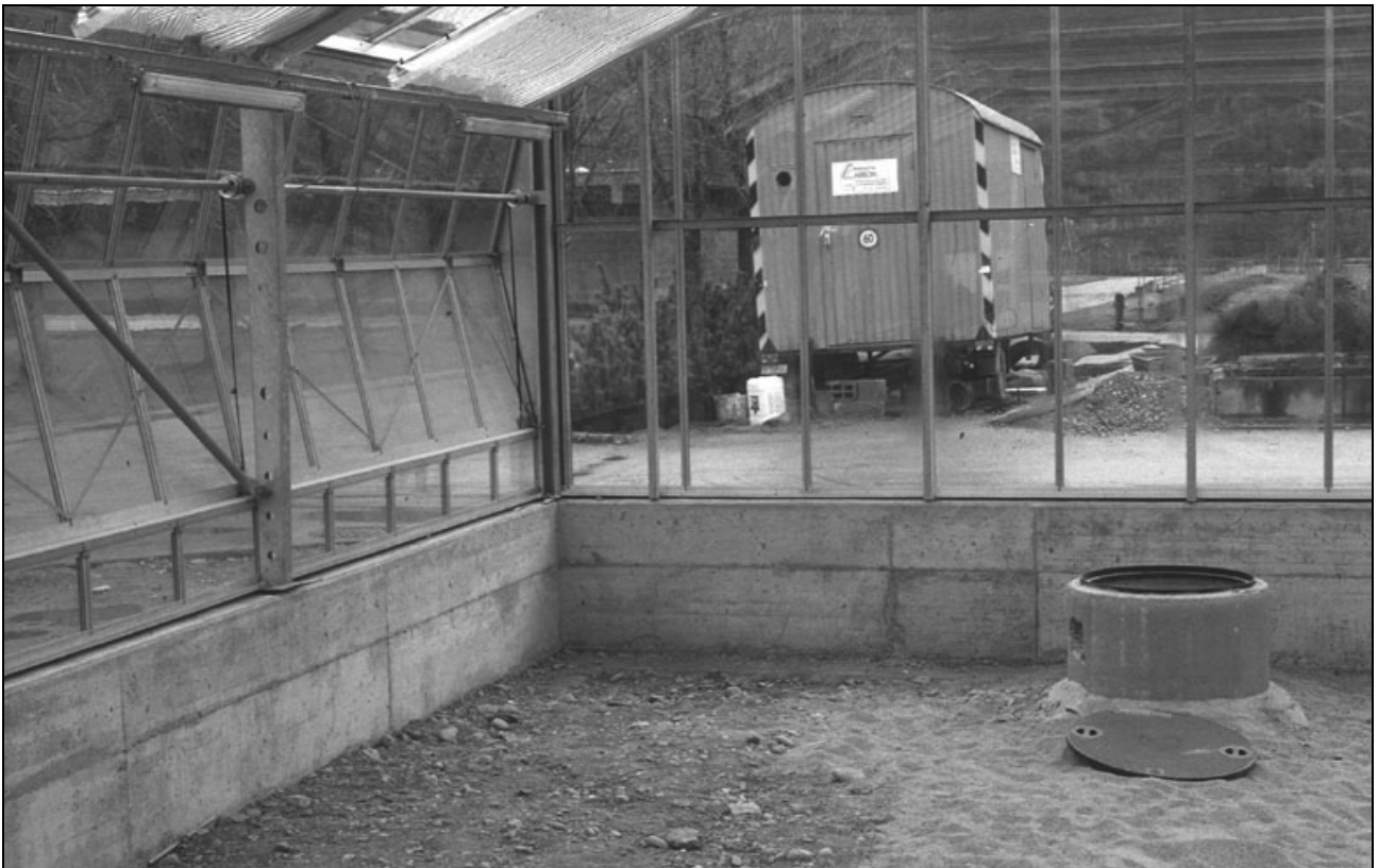
Figure 3 : Serre à eau : a) système hydraulique et aéroconvecteur ; b) bouche d'accès à la cuve (avant remblayage).
