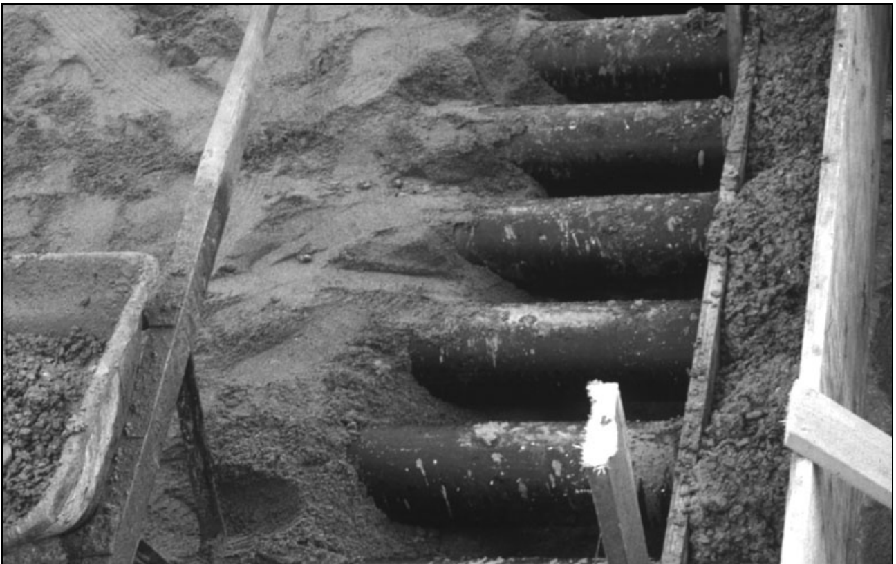
Figure 4 : Serre à air : a) aérochauffeur et cheminée d'entrée au stock ; b) registre de tubes enterrés (pendant remblayage).
